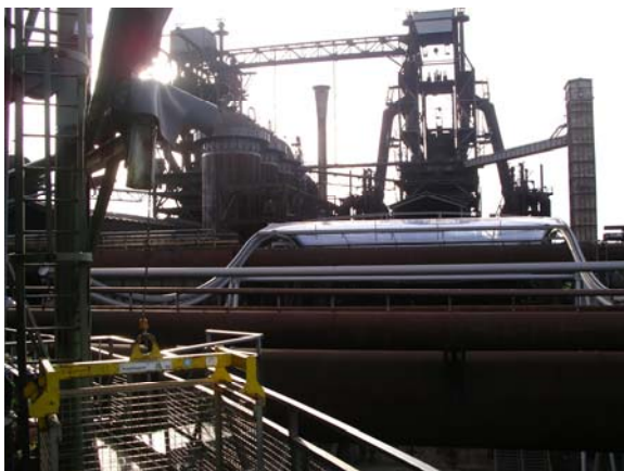
Acoustic Emission Test an Behälter und Rohrleitungen
